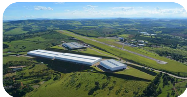
Centro Logístico e Industrial Aduaneiro Porto Seco Sul de Minas
